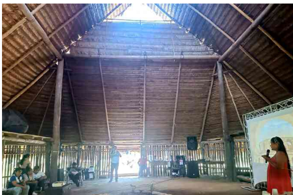
Figura 1. Estructura interna de la casa grande ancestral del pueblo Murui
